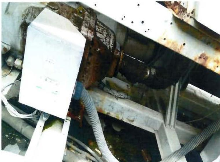
También debemos considerar el daño causado por el salitre, debido a la cercanía del mar a las instalaciones del Palacio de Bellas Artes, esto afecta de manera significativa estos equipos, ya que provoca un deterioro más rápido de los componentes mecánicos que conforman los equipos y el sistema de tuberías que utilizan los mismos.
