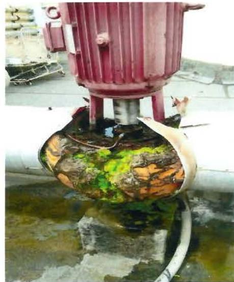
Estos equipos aunque fueran sometidos a reparaciones, los mismos tendrían una corta duración, debido a los constantes escapes de fluidos que suceden debido al mal estado de las tuberías de cobre y hierro, así como el desgaste de componentes electromecánicos y eléctricos.
